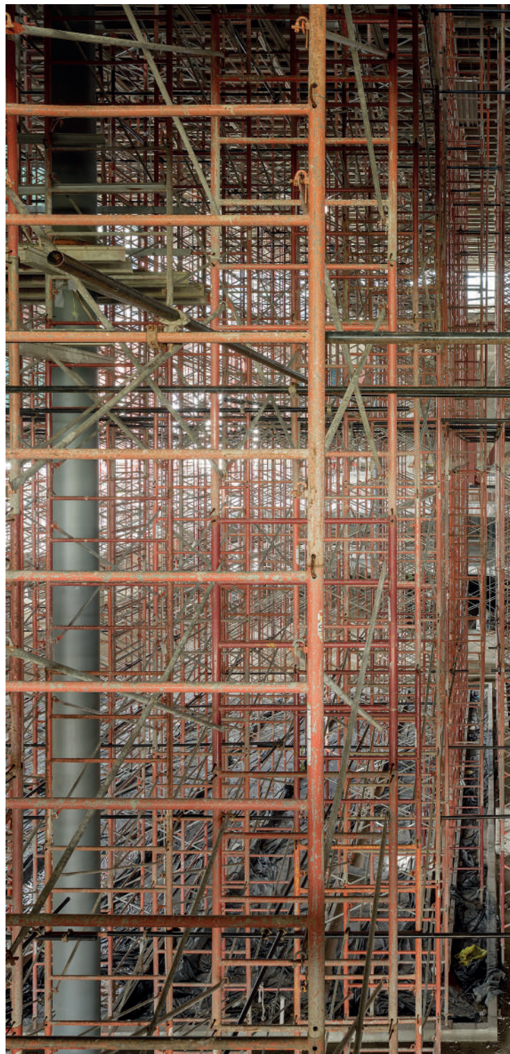
Pacific Center en construcción. Obra en Panamá. Pacific Center em construção. Obra no Panamá.
