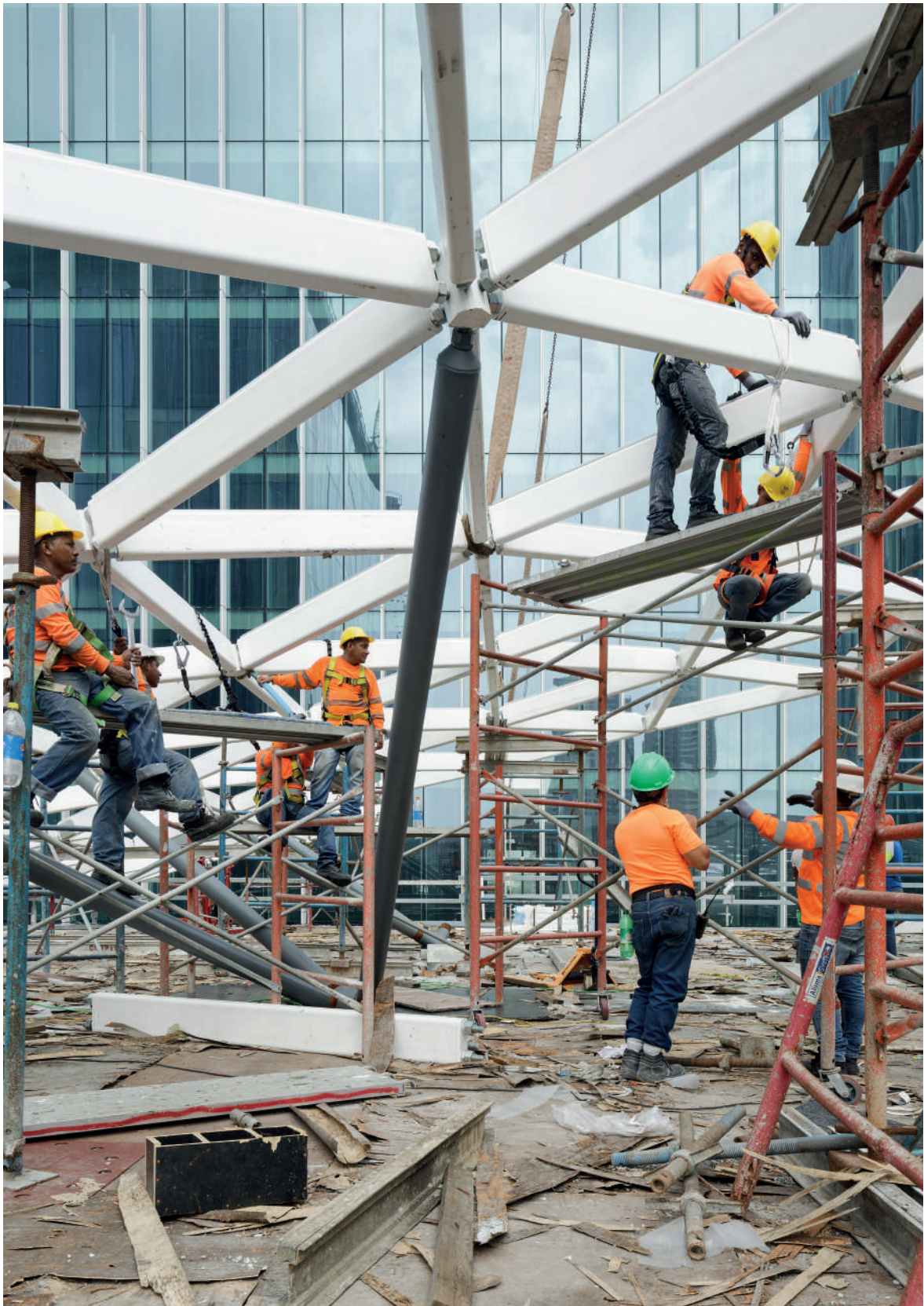
Pacific Center en construcción. Obra en Panamá. Pacific Center em construção. Local de construção no Panamá.
